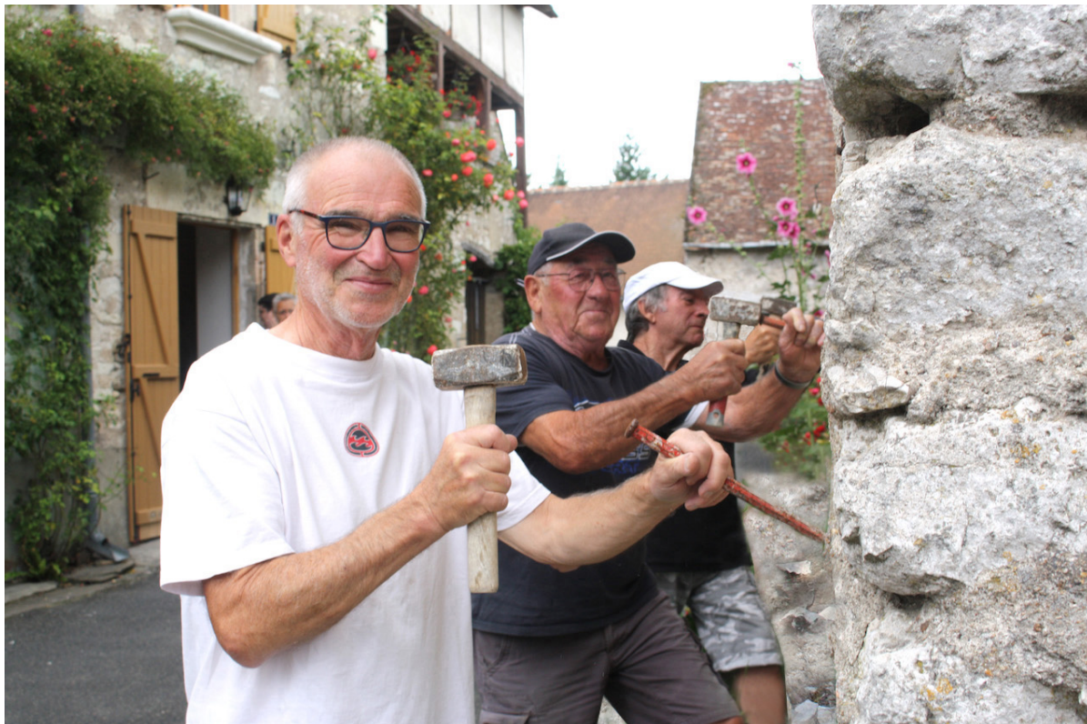
Bernard Talichet et deux amis, Hubert et Jean, lors d'une démonstration de piquetage.
